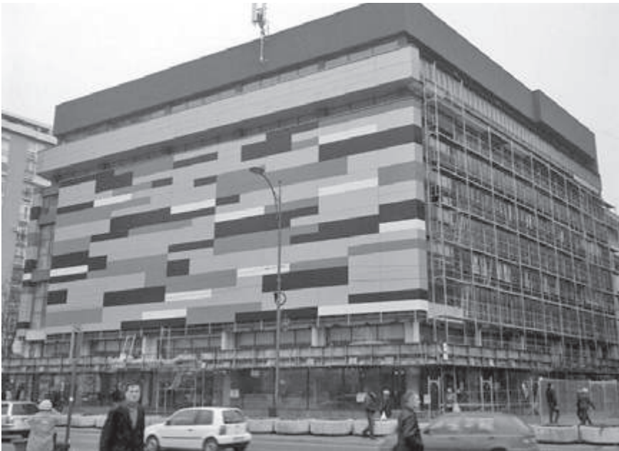
Slika 1: Nekadašnja Robna kuća Beograd, oblaganje fasade zarad preinačavanja u H&M
