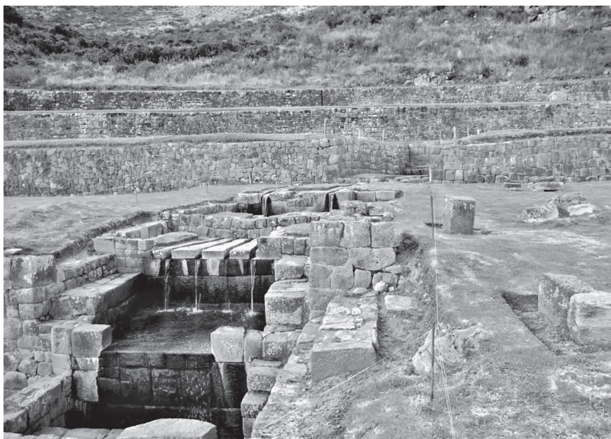
Hidraulički sistem u Tipónu – odvođenje i raspodela vode ka poljoprivrednim terasama.
